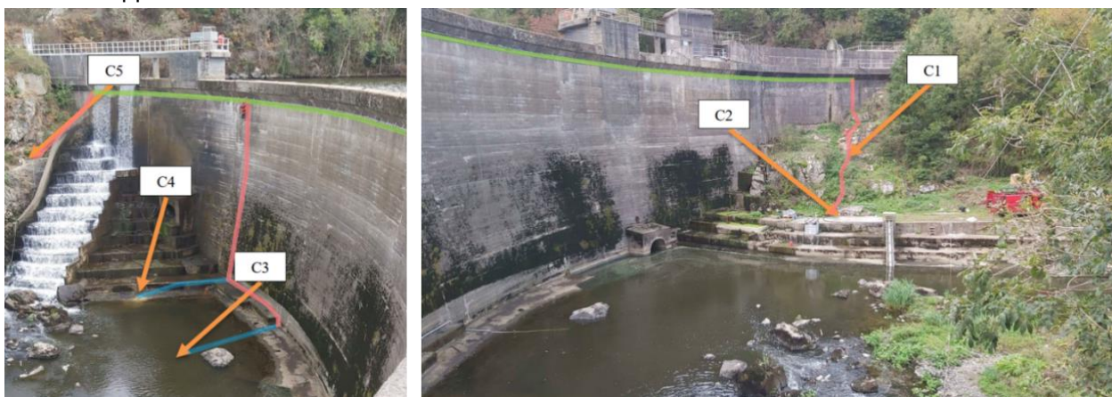
Figure 1-13 : Cheminement sommaire du câblage des piézomètres
